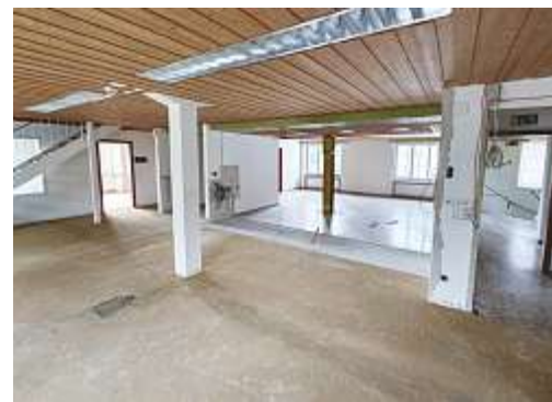
Und nach dem Rückbau.
