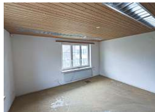
Und nach dem Rückbau.
