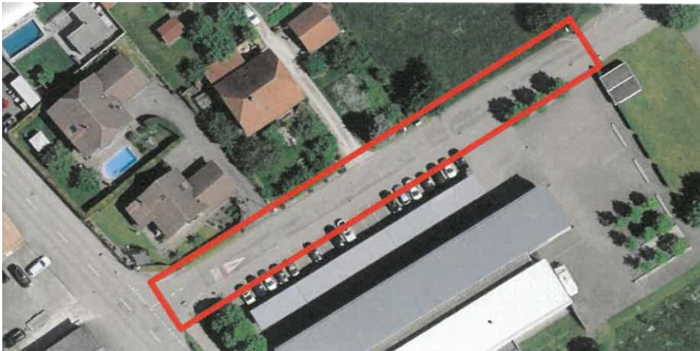
Strassenperimeter Chäsiweg West
