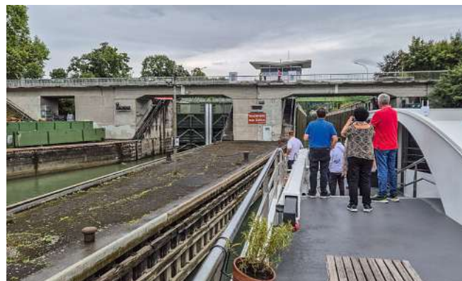
Einfahrt in die Schleuse Birnsfelden.
