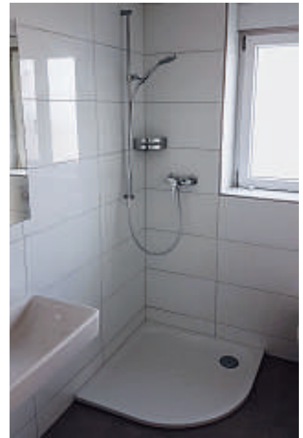
Nach der Sanierung in neuem Glanz.
