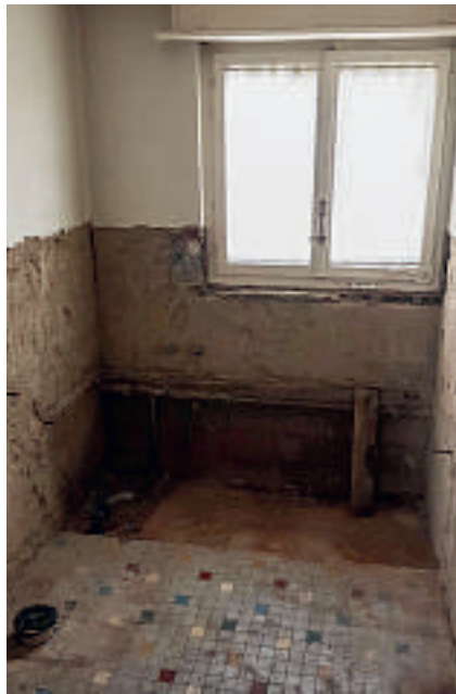
Die Bäder mussten komplett saniert werden.
